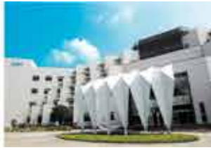
台南研發中心 (鑽石級綠建築)
