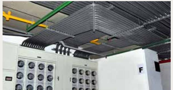
電導管工程 Electrical engineering
