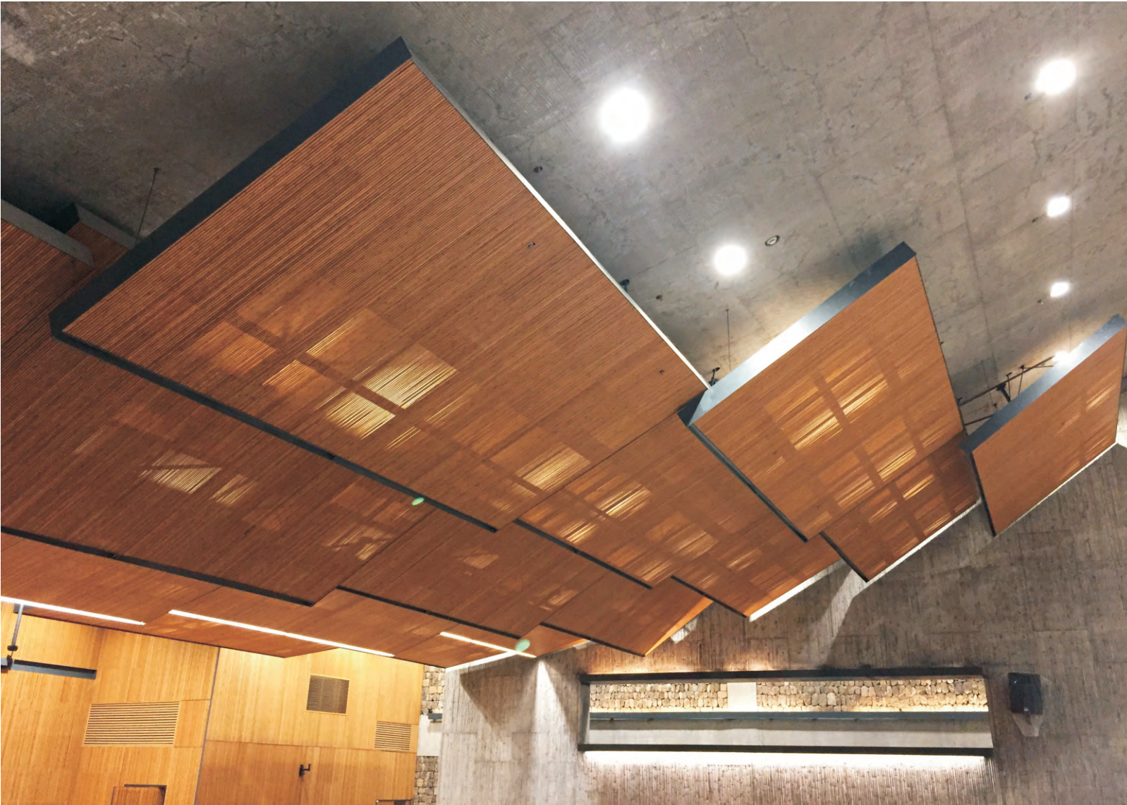
材料: 竹格栅组合吊顶, 竹饰面墙
