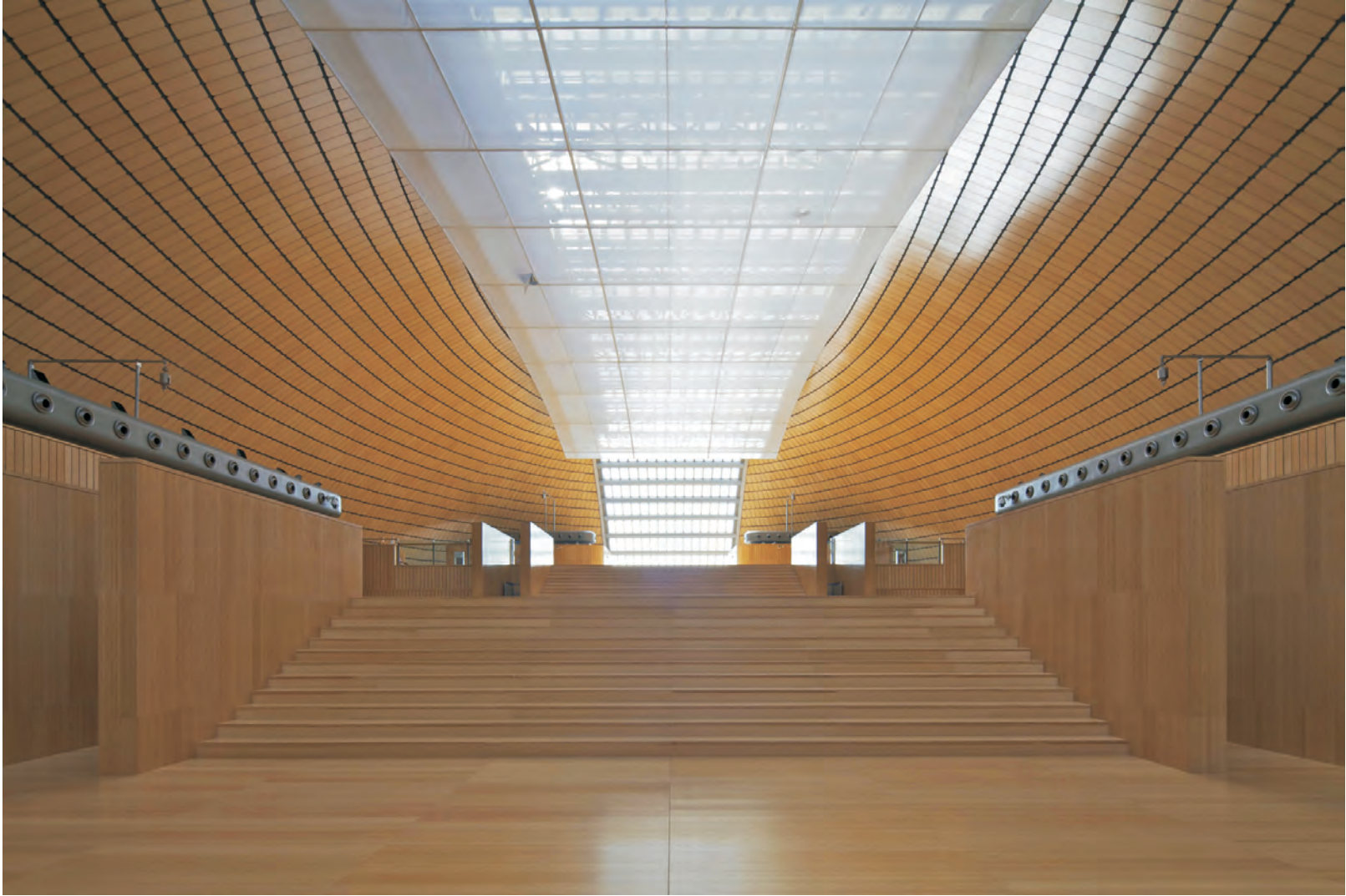
材料：竹加铝蜂窝吸音板，规格900x400x20mm, 表面有穿孔，孔径1mm。
