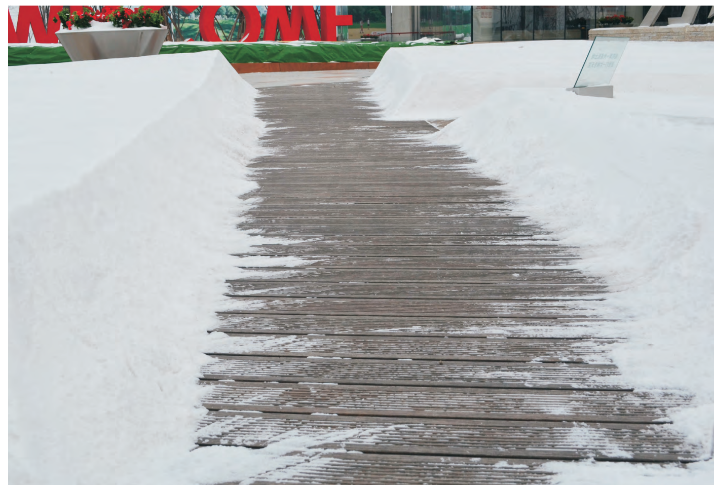
第二天来到项目现场回访, 此景是耐腐竹材料在严冬环境被厚厚冰雪覆盖的场景
