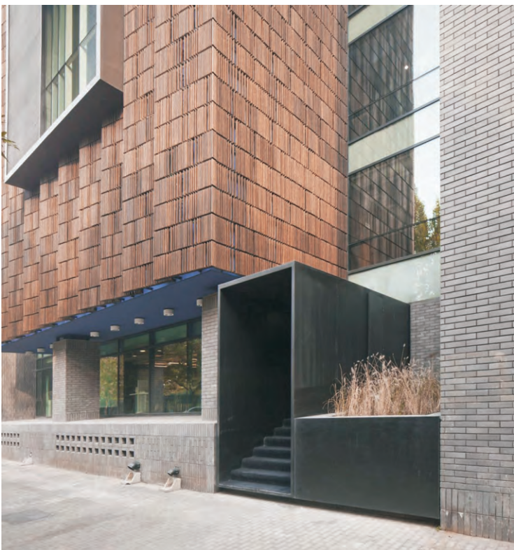
设计：外墙，内装主体材料均为高耐户外格栅（深色）1860x100x30mm可裁短从新组合
