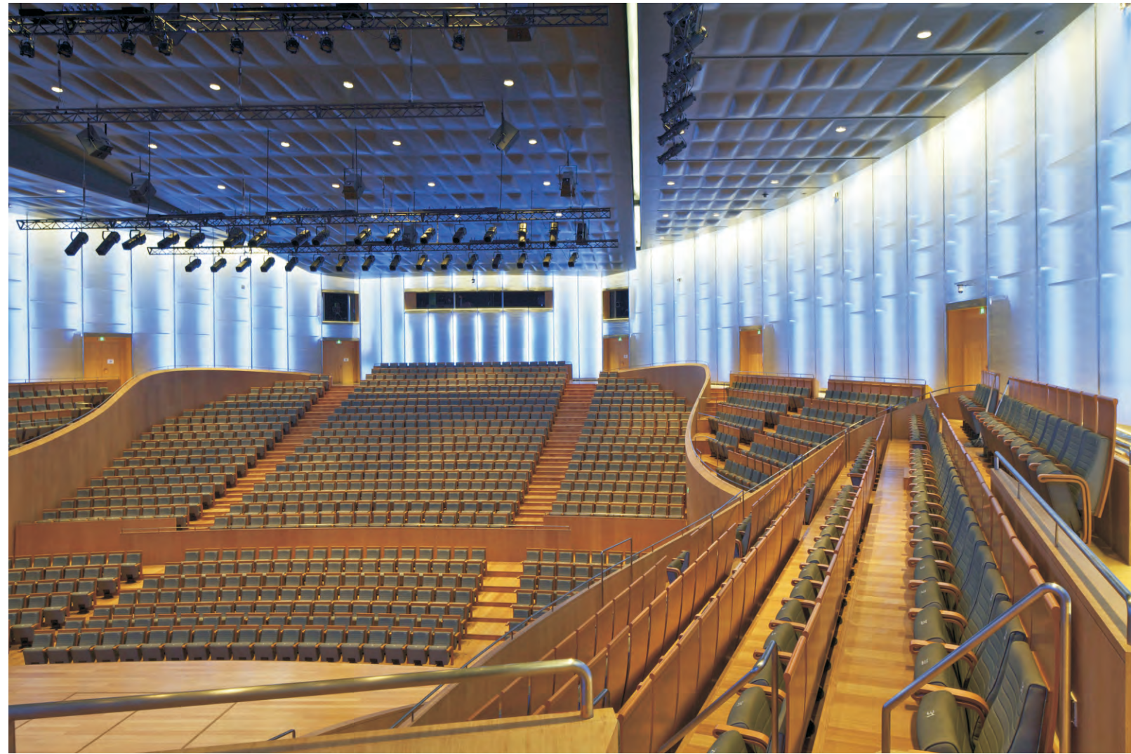
建筑室内主要用材是大穹顶, 此外, 全部坐椅, 门, 墙板, 地板均为竹材
