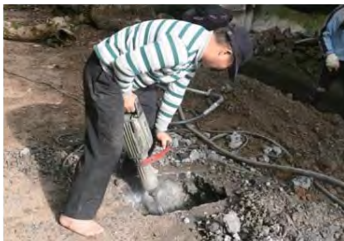
與樹根上二層水泥一層瀝青，須動用大型電動鑿子才能敲除，根還能生存嗎？
