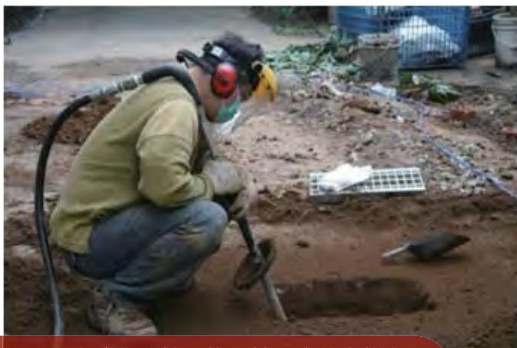
採用保根挖掘系統，將樹根土壤清出後加以改良土壤化學性及物理性，由於老樹在此生活已久，樹下必然存在許多賴以為生或支撐龐大樹體的根系，採用一般挖掘工具難免會挖到樹根，所以採用保根挖掘系統，在不傷根的情況下將樹根間的土壤挖起，並加以改善其排水、透氣、營養…物理特性，營造出適合根及益菌的生長環境。
