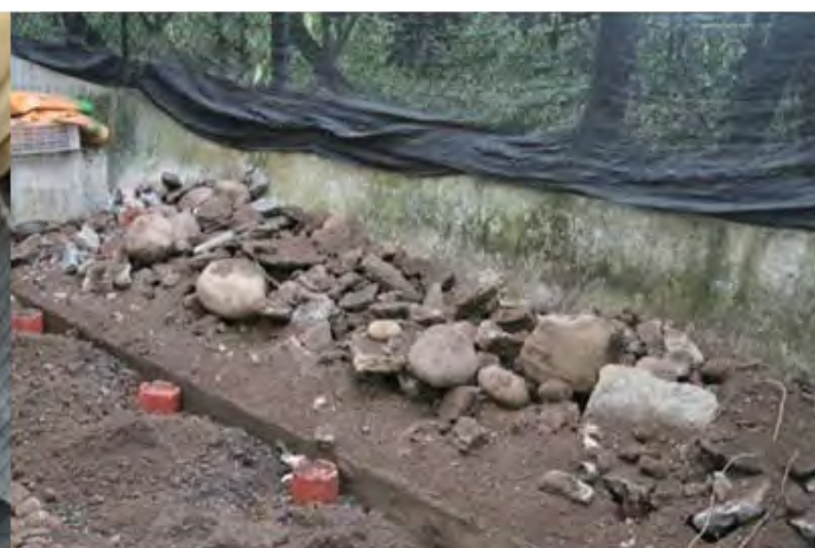
從原本棲地挖出，有許多的大石頭，這是建造樹旁水溝的工程廢棄土。
