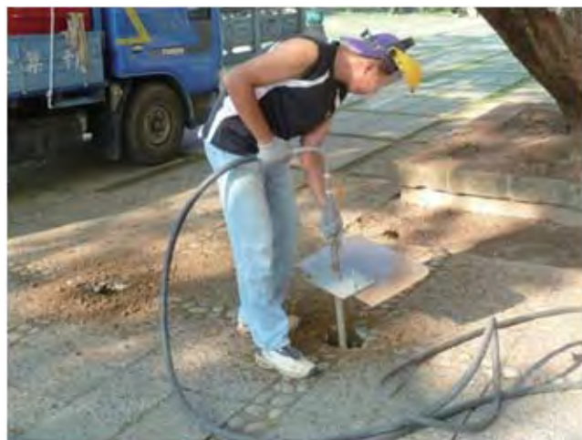
採用保根挖掘系統改良土壤。
