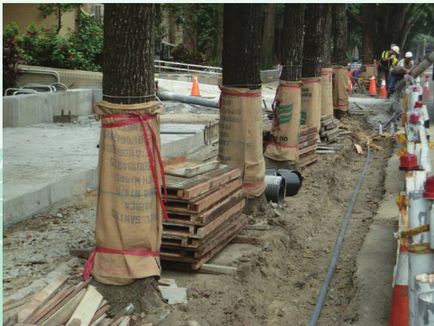
樹下施工時樹皮的保護，是非常重要的。
