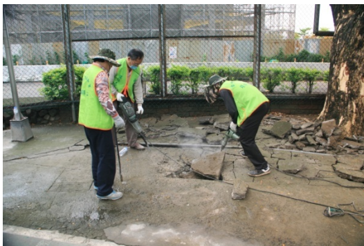
採用大型電動鑿才能破壞水泥結構
