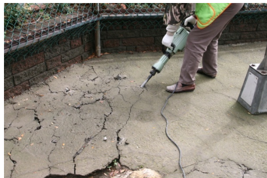
採用大型電動鑿才能破壞水泥結構
