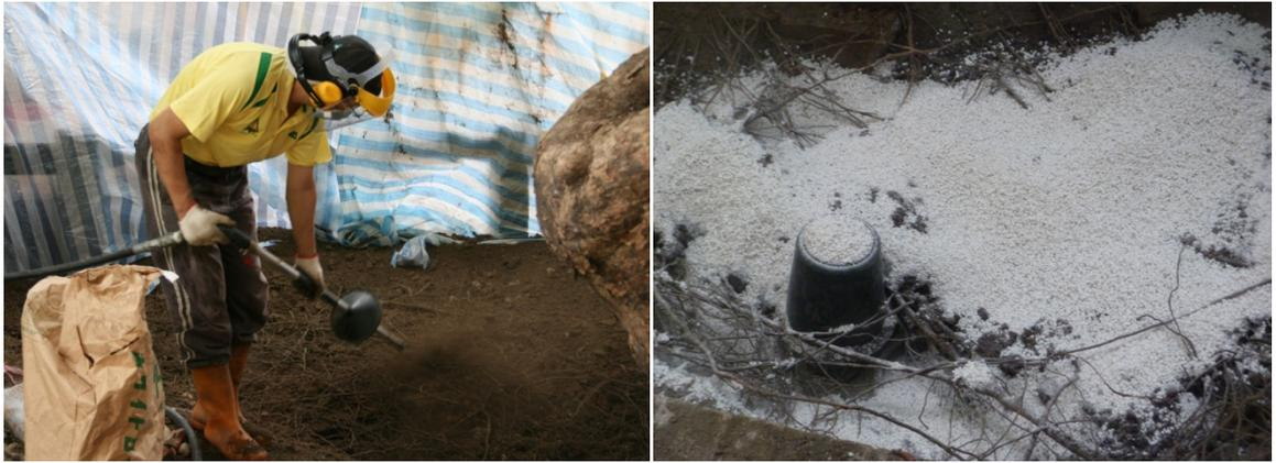
以保根挖掘系統將棲地上工程廢棄土取出，將根下方不透水層打破埋入酸素管以增加土壤排水通氣性，將土壤拌合黑曜石發泡粒、泥炭土..好的資材，配合共生菌的環境的配置，讓樹根在自然環境中生長。
