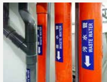
下水道工程 Sewer Engineering
