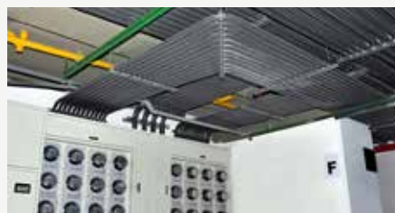
電導管工程 Electrical engineering
