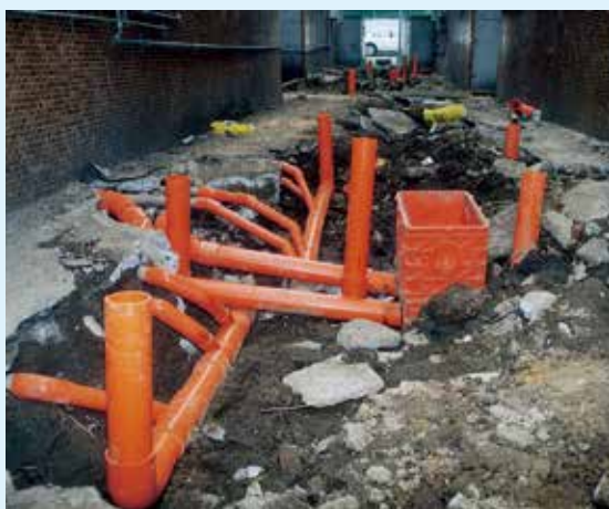
下水道排水配管 Sewer Engineering
