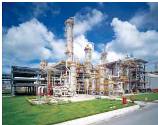
石化工廠 Petrochemical plant
