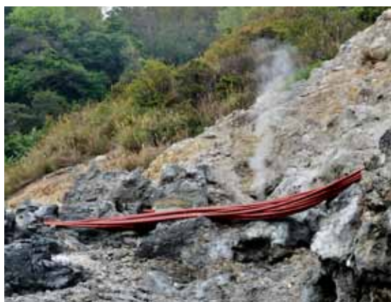
溫泉配管 Hot Spring piping
