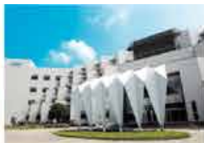
台南研發中心 (鑽石級綠建築)
