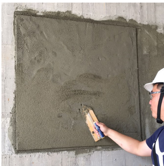
使用抹刀將表面鏟成均勻粗面
