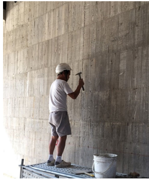
剔除牆面不平整
