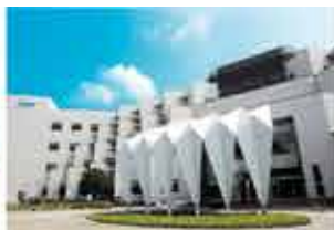
台南研發中心 (鑽石級綠建築)
