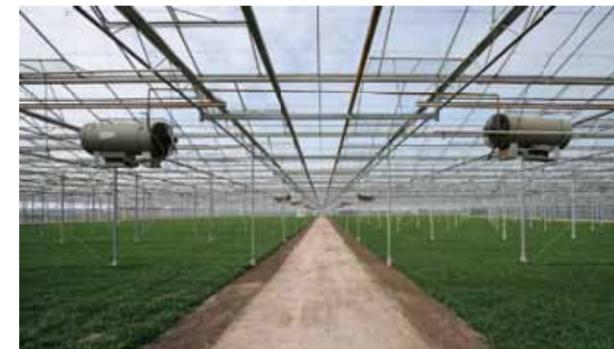
在寒冷季節可自動操作鍋爐或加熱器，讓溫室保持溫暖，使植物穩定成長。也可以透過定期換氣來調整CO<sub>2</sub>濃度。
